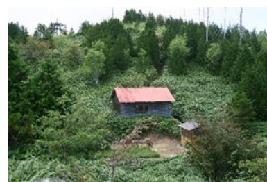
(避難小屋と左トイレ)
